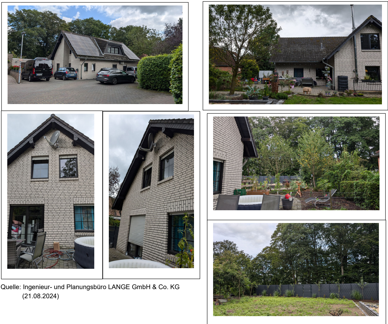
Abbildung 2 Foto-Dokumentation (Wohngebäude Blick vom Wendehammer und vom Garten, Giebelseite, an die angebaut werden soll, rückwärtiger Garten
